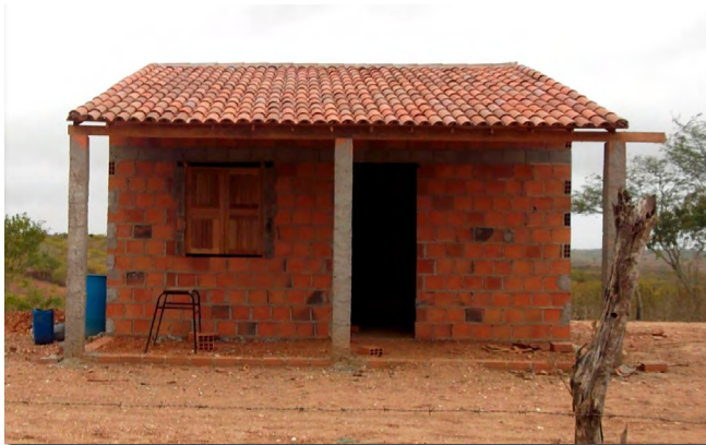
Figura 5.9. Moradia camponesa, Comunidade Retiro, Sergipe
