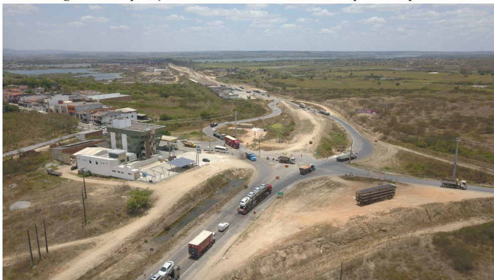
Figura 22. Duplicação da BR-101 no Acesso ao Município de Propriá/SE
