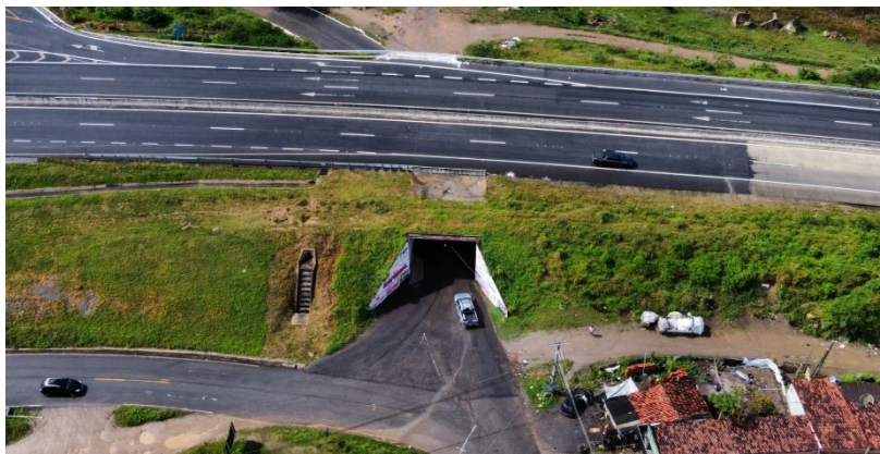
Figura 11. Passagem Inferior, Propriá/SE
