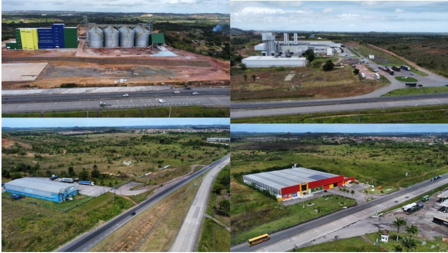
Figura 27. Instalação de Indústrias às margens da BR-101/SE, Lote 3 e 4/SE
