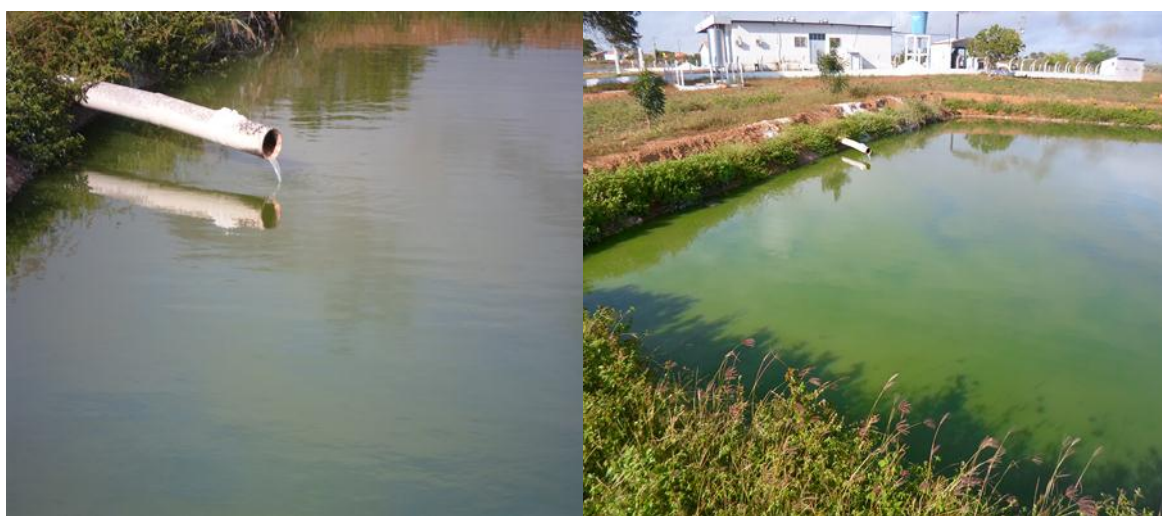
Figura 3: Lagoa de decantação onde são lançados os efluentes líquidos do Laticínio Esperança.
