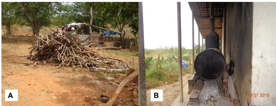
Figura 10: (a) Lenha para utilização das fabriquetas; (b) Caldeira mantida a lenha, Tanque de Pedra/SE.
