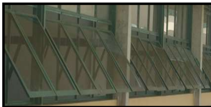
Figura 3 – Utilização de janelas tipo basculante nos blocos do IFS - Campus Lagarto.
