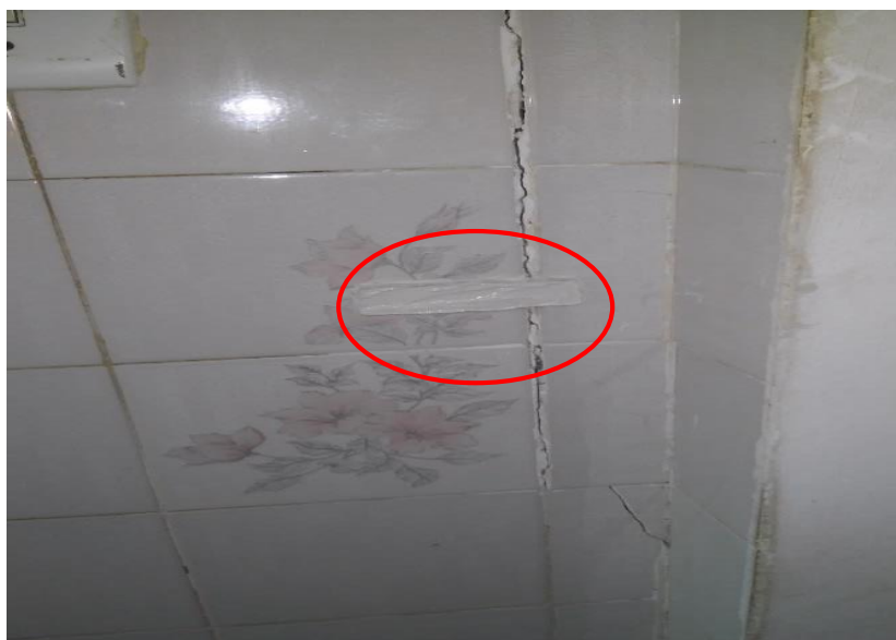
Figura 16 – Placa de gesso para verificação de vibração na estrutura.
