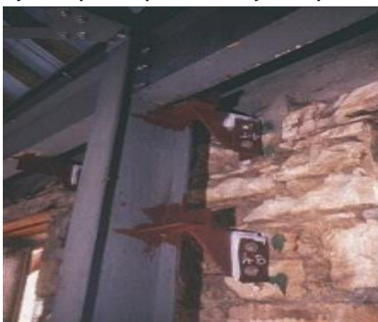
Figura 4 - Inserção de pilares para contenção de paredes de alvenaria.
