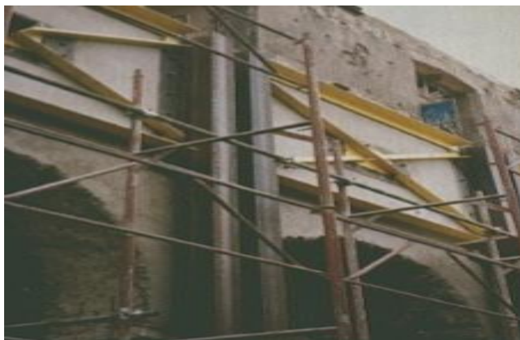
Figura 5 - Contraventamento em “X” de parede de alvenaria existente.
