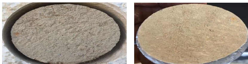
Figura 18: Corte e CP 2 retirado da fachada
