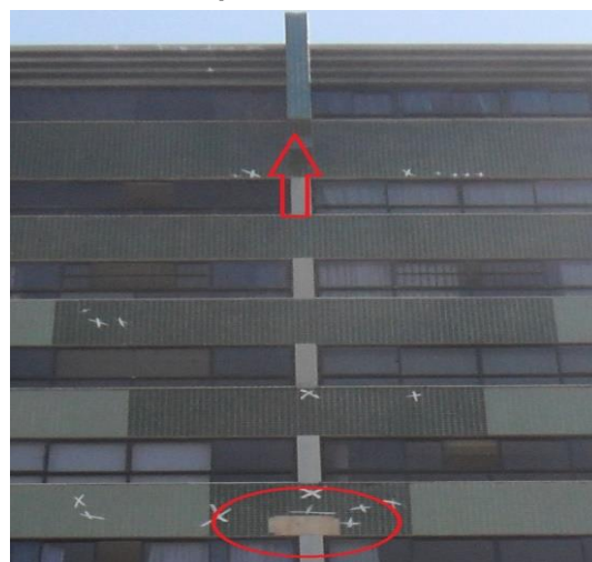
Figura 12: Fachada frontal e detalhe de deslocamento
