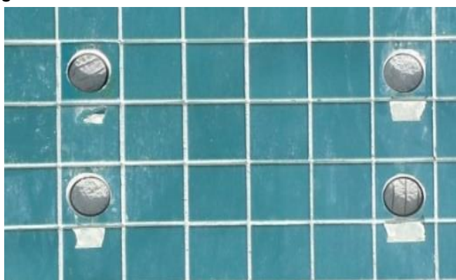
Figura 15: Teste de aderência no revestimento cerâmico
