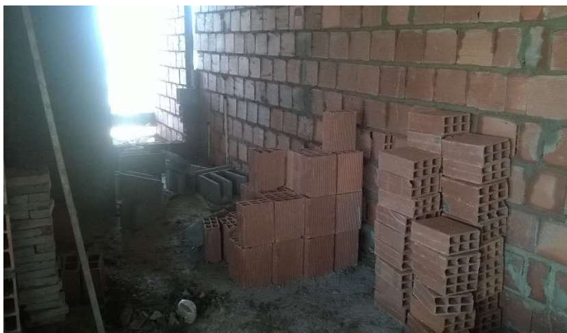
Figura 22- Armazenamento de blocos cerâmicos no pavimento (02)
