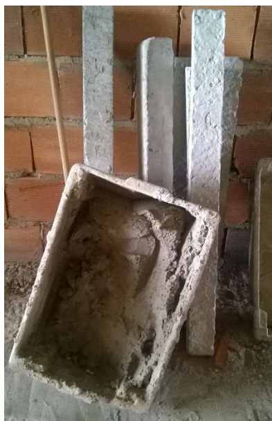
Figura 14 - Perda de argamassa por endurecimento no recipiente
