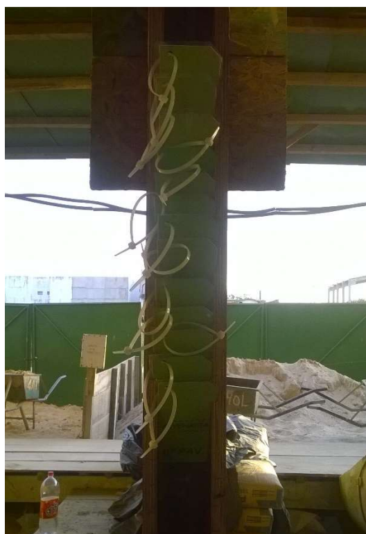
Figura 13 - Caixa para os cartões próximo à central de argamassa
