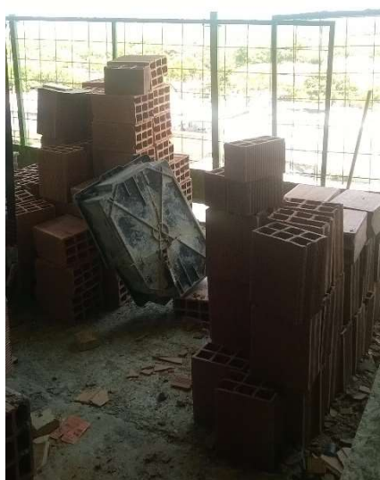
Figura 21 - Armazenamento de blocos cerâmicos no pavimento (01)
