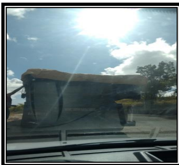
Figura 36 - Transporte do CBUQ para o local de execução.
