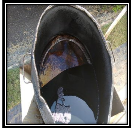
Figura 41 - Pintura de ligação.
