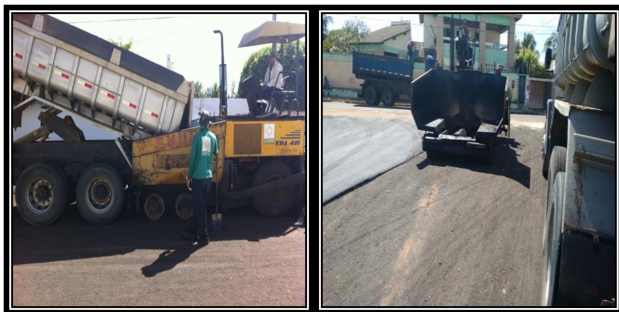
Figura 43 - Vibro-acabadora e lançamento do CBUQ na vibro-acabadora.
