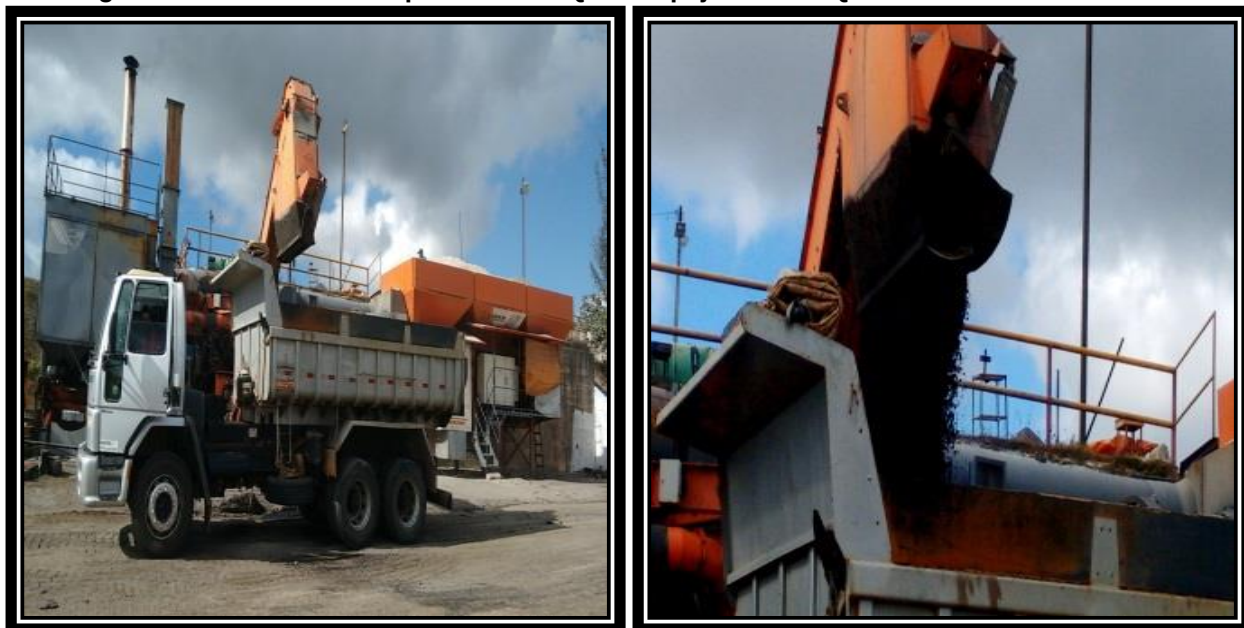
Figura 35 - Caminhão a espera do CBUQ e despejo do CBUQ em caminhão basculante.
