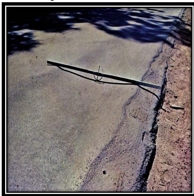
Figura 11 - Afundamento.
