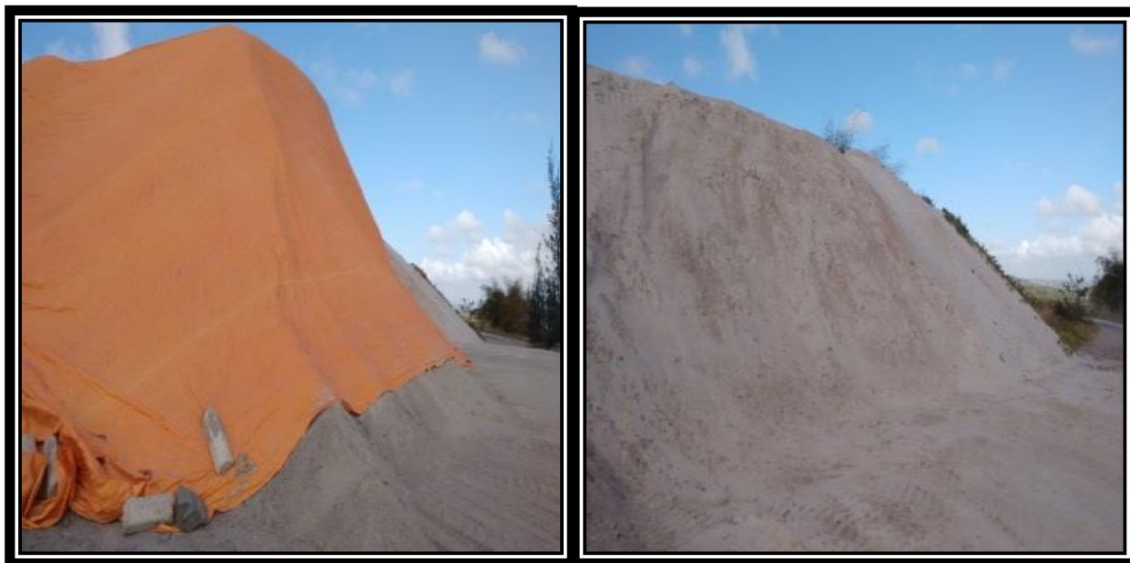
Figura 27 - Armazenamento de areia com e sem proteção.
