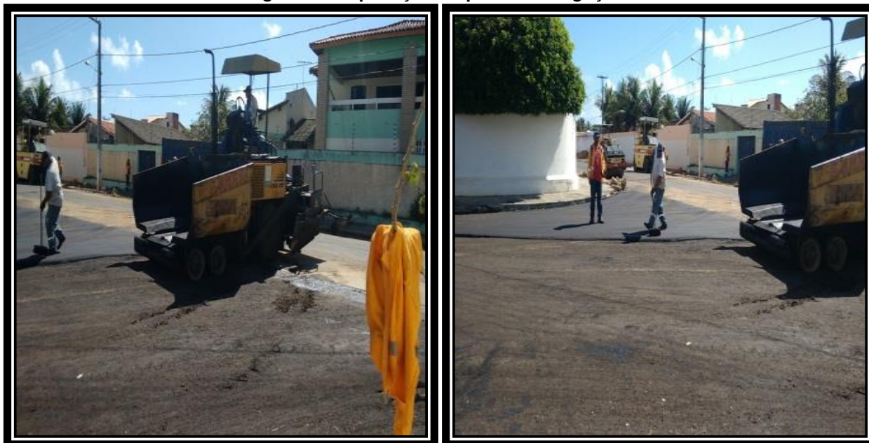
Figura 42 - Aplicação da pintura de ligação.
