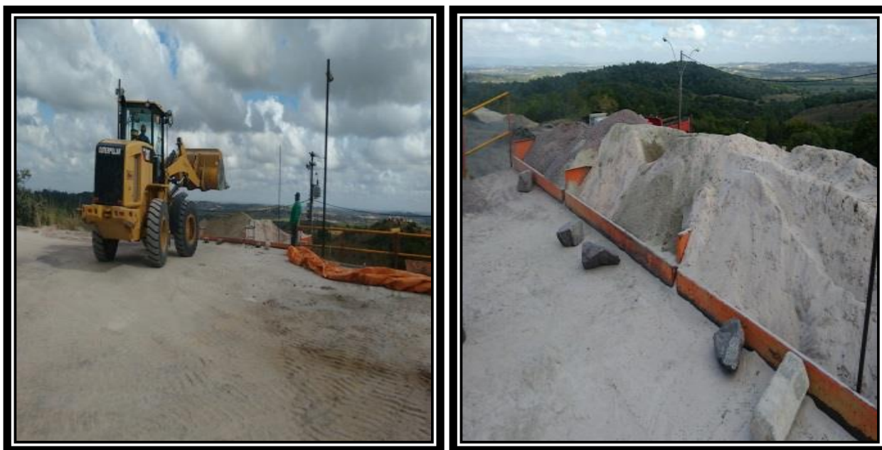
Figura 28 - Retroescavadeira colocando agregados nos silos e seu armazenamento.
