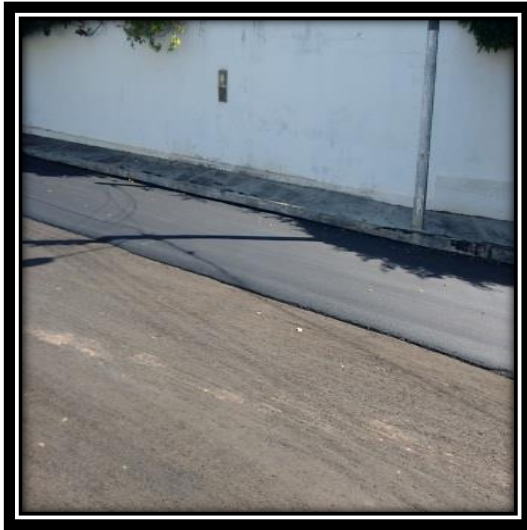
Figura 38 - Camada imprimada.
