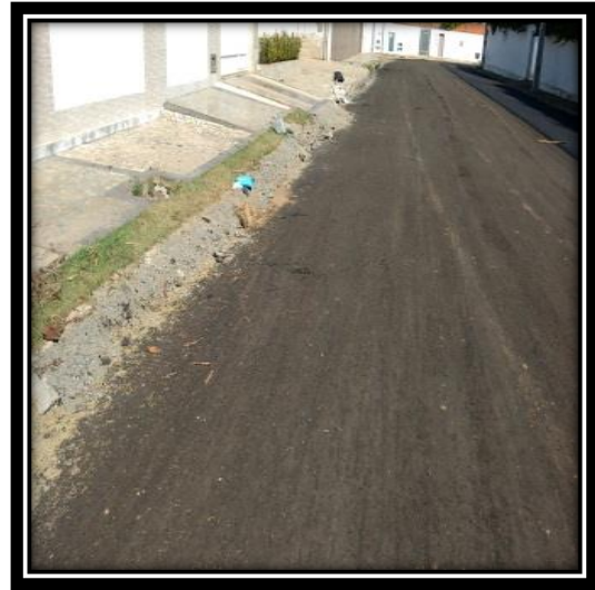
Figura 39 - Resíduos na via.
