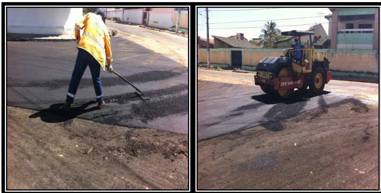
Figura 46 - Regularização manual e com rolo liso dos rastros do caminhão.
