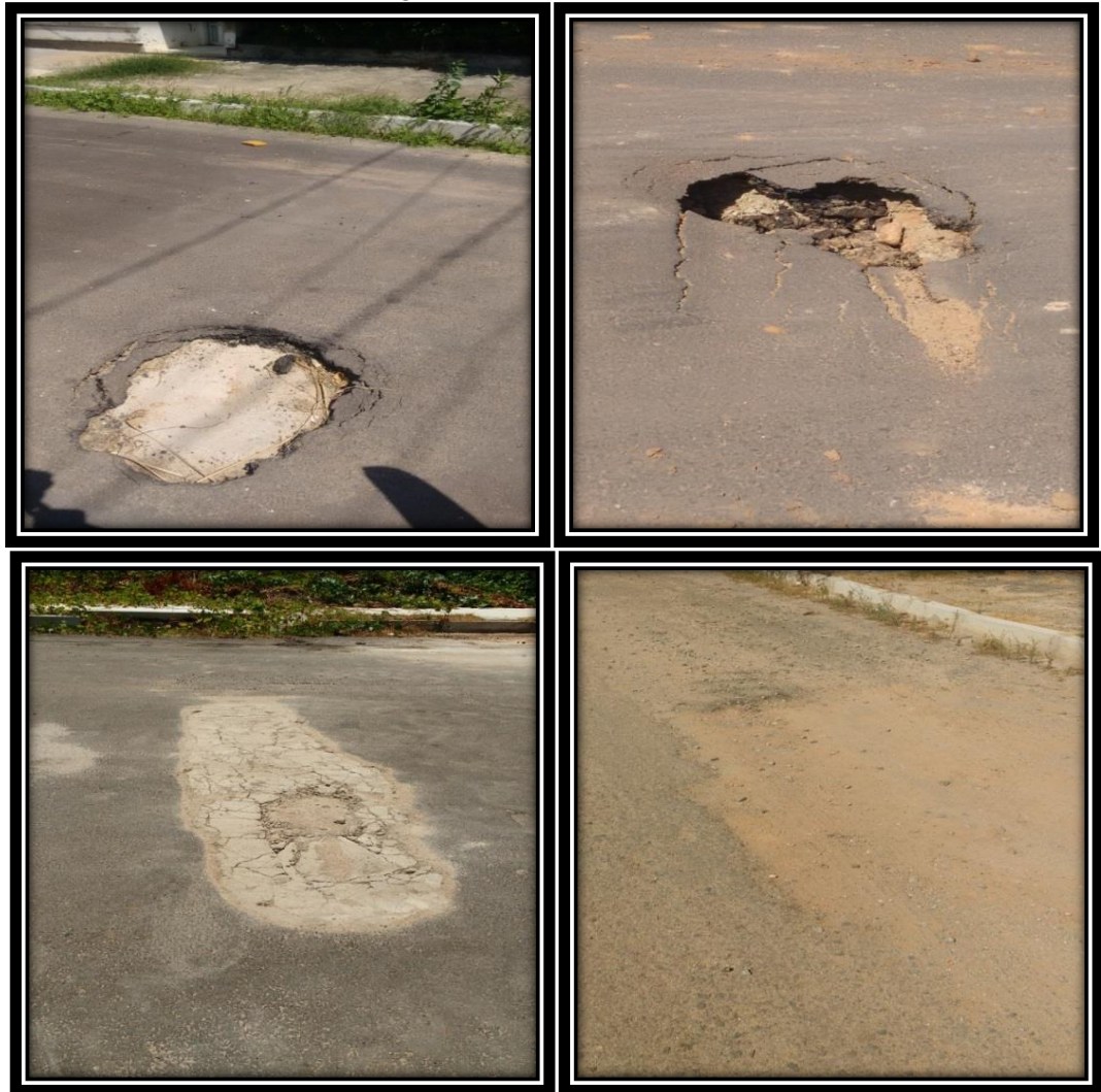
Figura 49 - Painéis na via.
