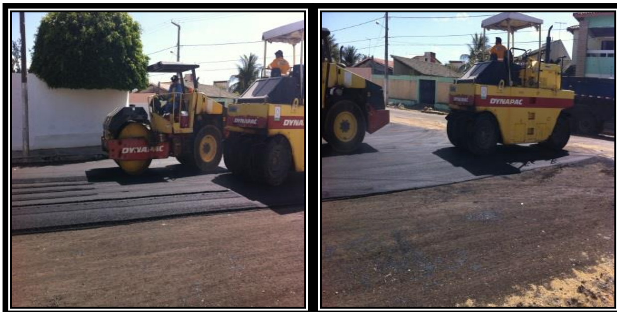
Figura 44 - Rolo liso usado antes do do rolo pneumático.
