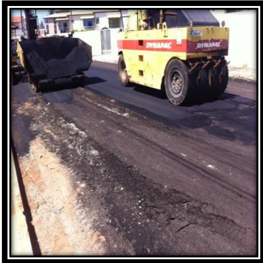
Figura 40 - Imprimação com imperfeições.
