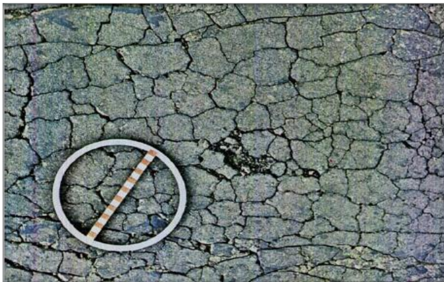
Figura 4.5 - Trinca tipo “Pele de Crocodilo”
