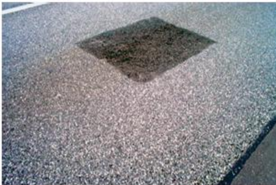
Figura 4.15 - Remendo
