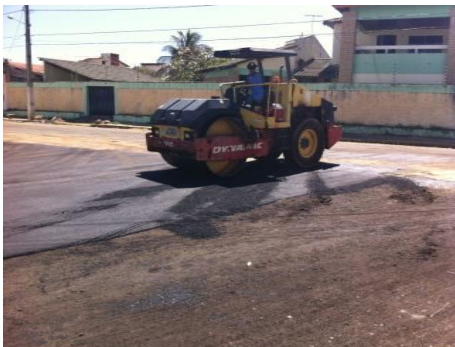
Figura 6.6 - Regularização de trilhas de roda com rolo compactador
