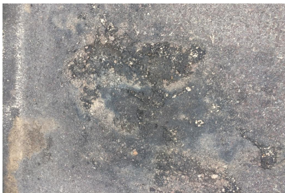
Figura 6.13 - Desgaste
