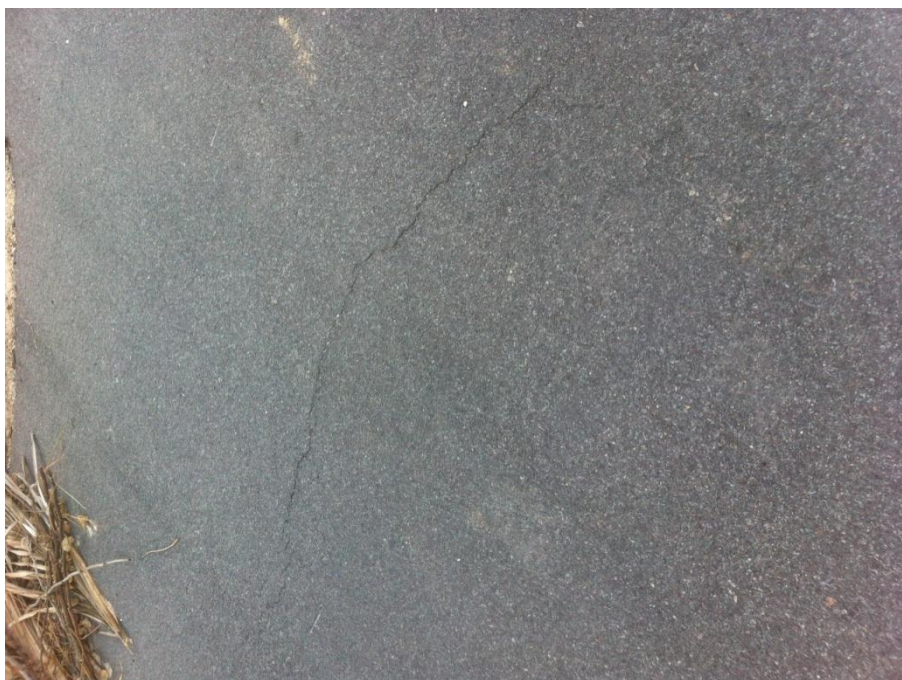
Figura 6.14 - Trinca transversal
