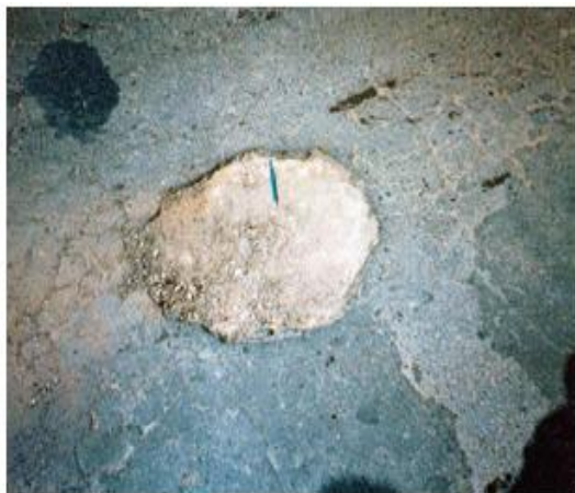
Figura 4.13 - Panela Atingindo a Base
