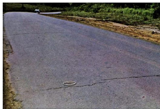
Figura 4.3 - Trinca Transversal
