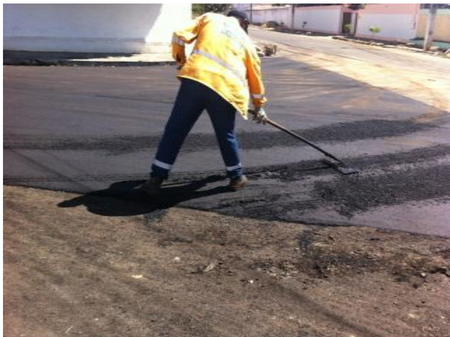
Figura 6.7 - Regularização manual das trilhas de rodas
