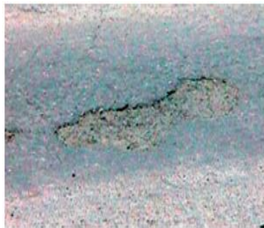
Figura 4.14 - Panela na Pintura de Ligação
