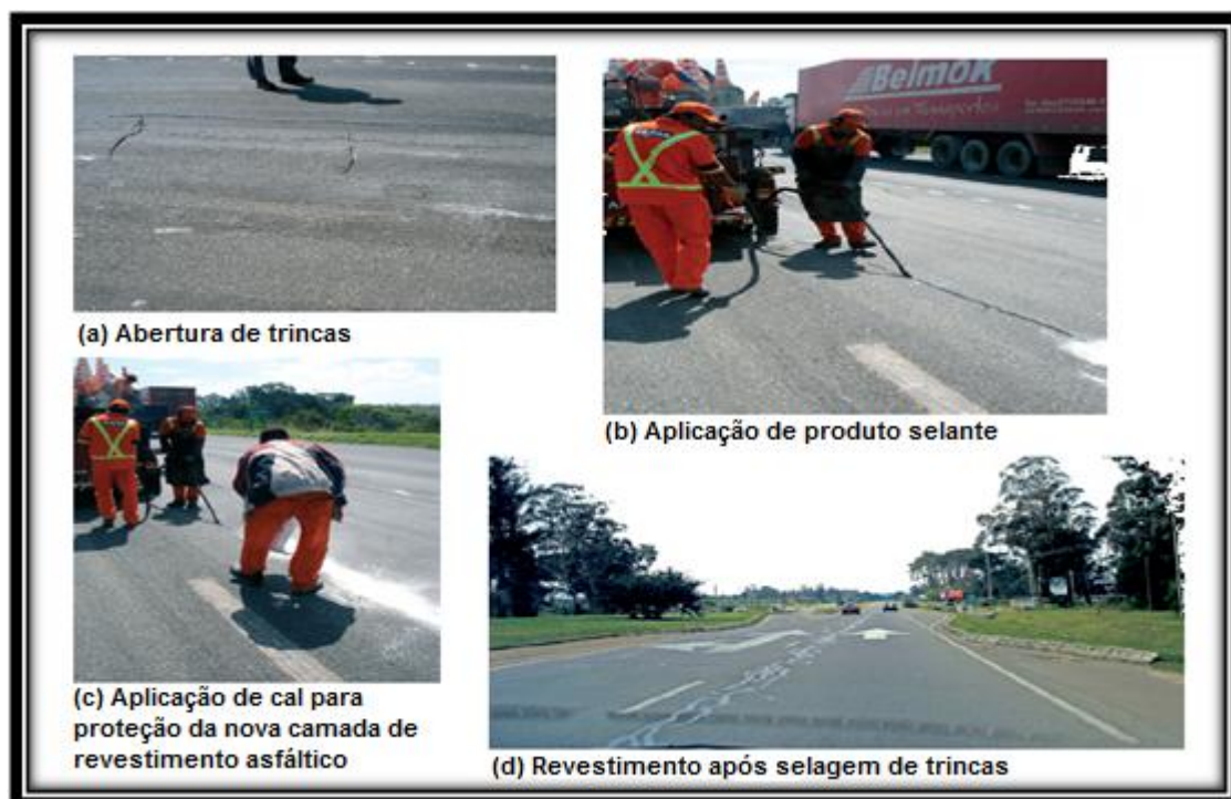
Figura 5.1 – Exemplo de selagem em trincas
