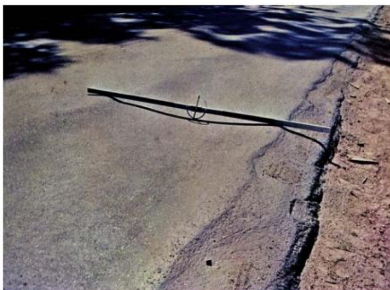
Figura 4.6 - Afundamento
