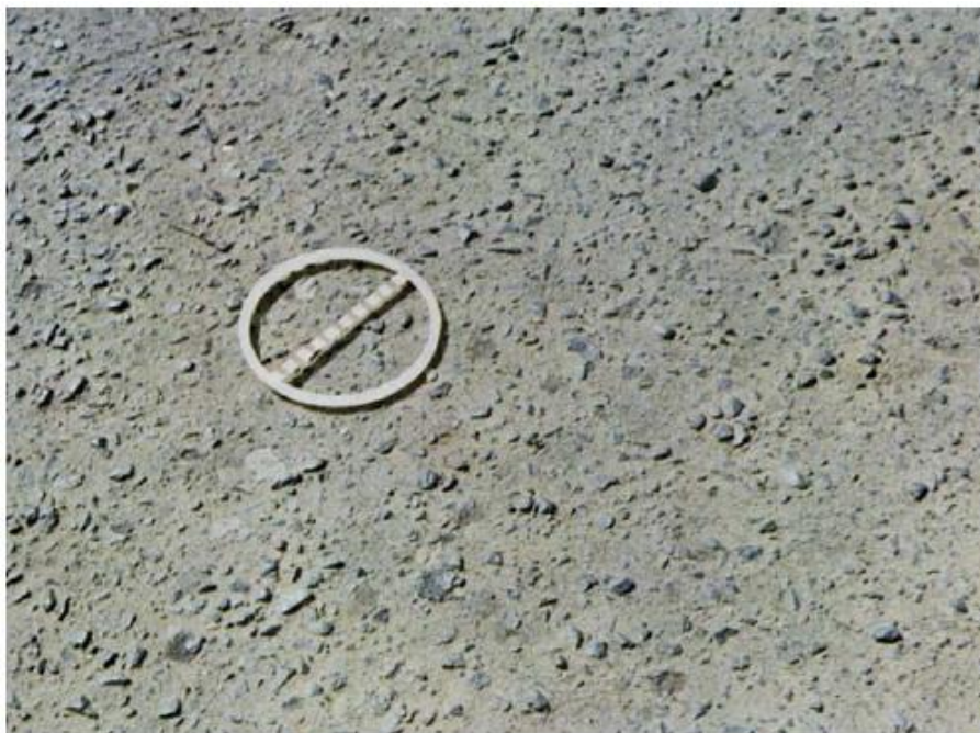
Figura 4.12 - Desgaste
