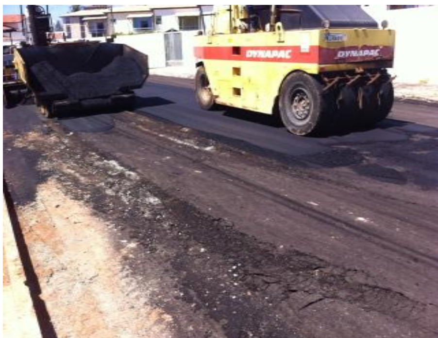
Figura 6.4 - Imprimação danificada
