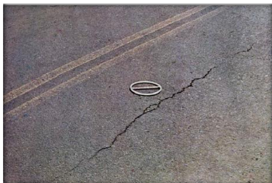
Figura 4.2 - Trinca Logitudinal
