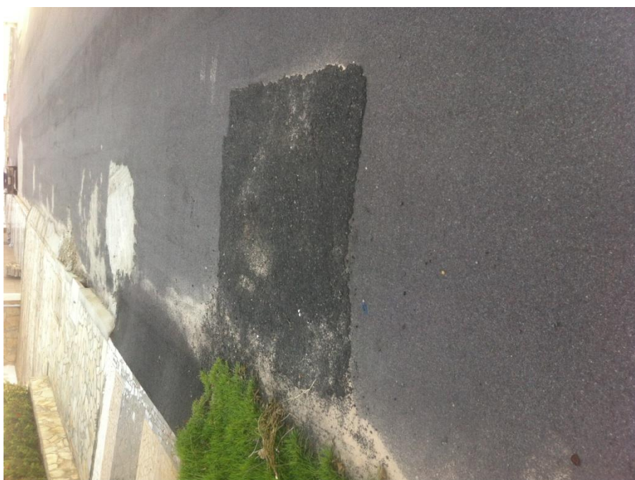
Figura 6.15 - Remendo
