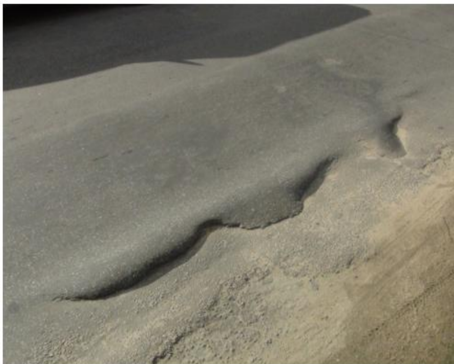
Figura 4.7 - Afundamento Plastico
