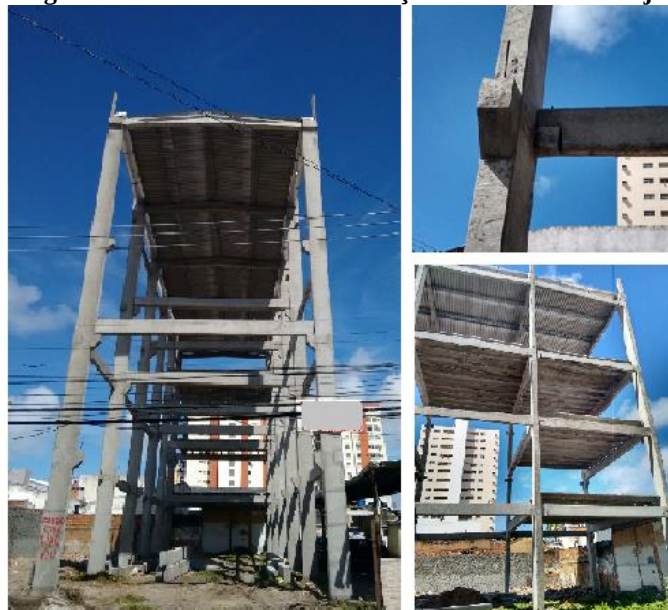
Figura 13 - Estrutura em construção situada em Aracaju
