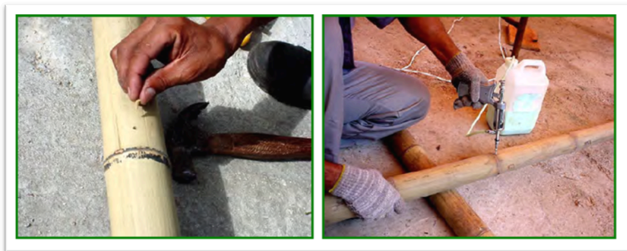
Figura 19 - Furo para injeção e Injeção da solução. Fonte: Pereira (2001)
