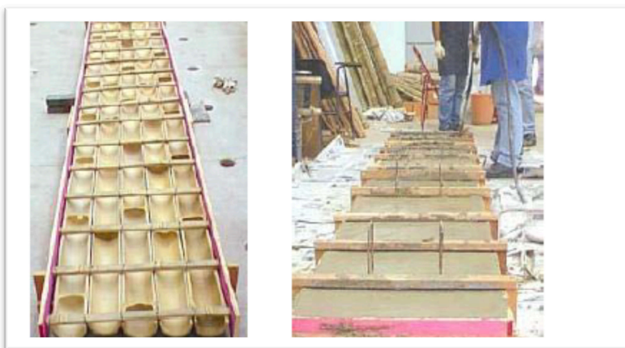
Figura 50 - Laje reforçada por bambu, forma de laje com reforço por metade da seção do bambu e concretagem da laje. Fonte: Ghavami (1995)
