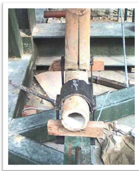
Figura 34 - Ruptura da Conexão SV 90° à tração. Fonte: Pereira (2001)
