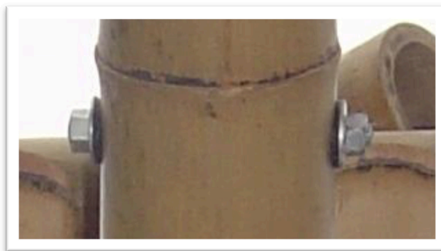
Figura 41 - Sistema porca, arruela de aço, arruela de PVC. Fonte: Pereira (2001)
