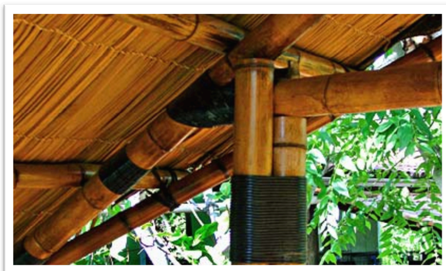
Figura 49 - Conjunto pilar/viga. Fonte: Ghavami (1995)
