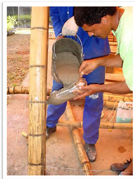
Figura 47 - Cimentando o pilar. Fonte: Pereira (2001)
