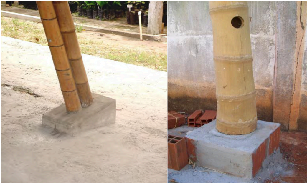
Figura 17 - Conjunto sapata/pilar. Fonte: Pereira (2001)
