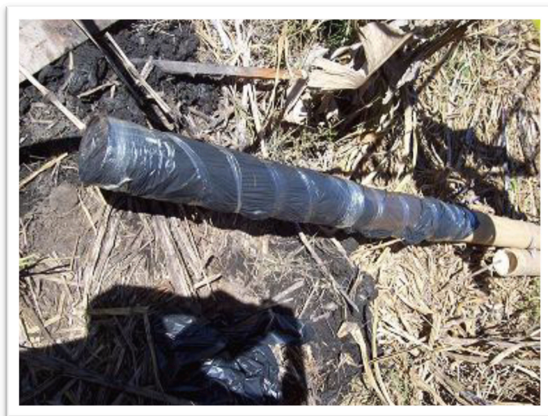
Figura 15 - Impermeabilização da vara com saco plástico para ser enterrada. Fonte: Pereira (2001)
