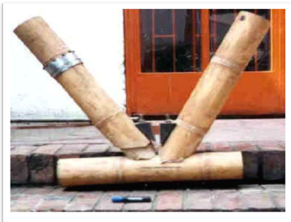
Figura 30 - Ruptura da conexão SV 60° devido à tração. Fonte: Pereira (2001)
