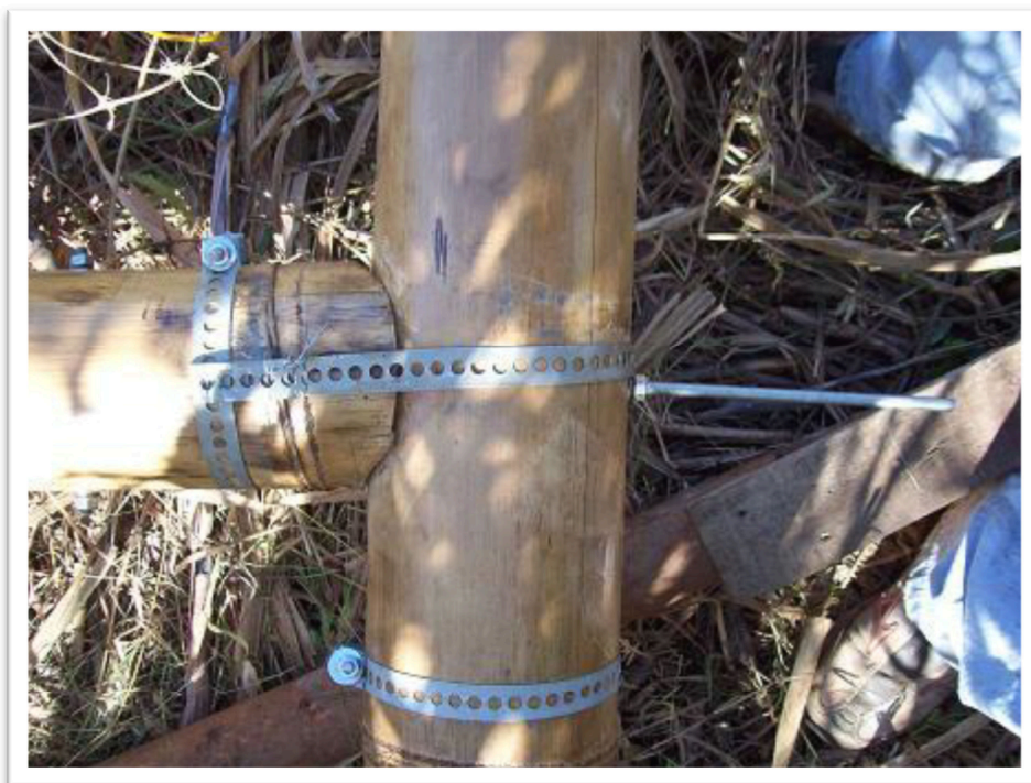
Figura 23 - Boca de pescado reforçada. Fonte: Pereira (2001)
