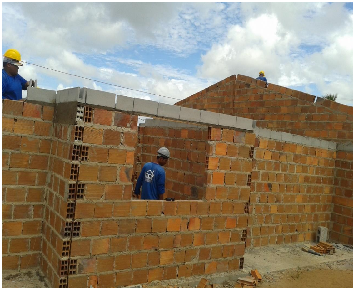
Figura 24 - Execução do Serviço com o uso dos EPI's - 01
