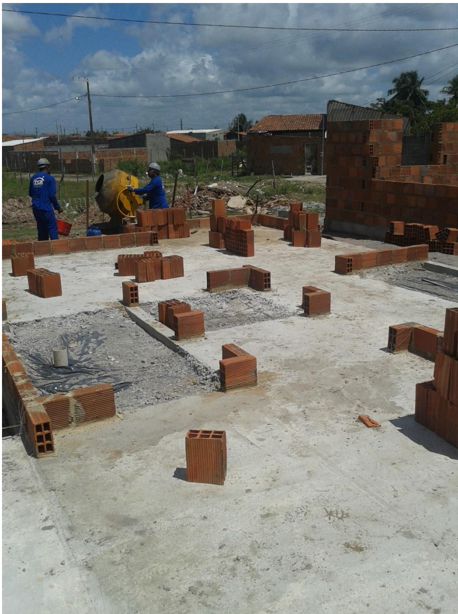
Figura 25 - Execução do Serviço com o uso dos EPI's – 03
