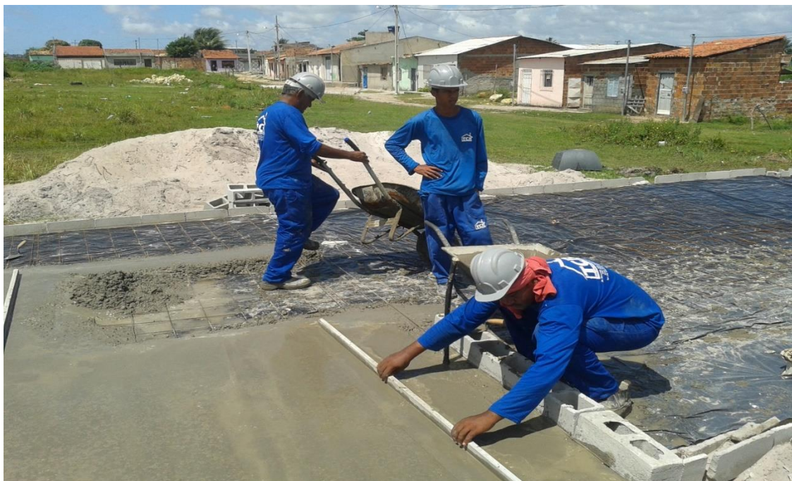
Figura 23 - Execução do Serviço com o uso dos EPI's - 02
