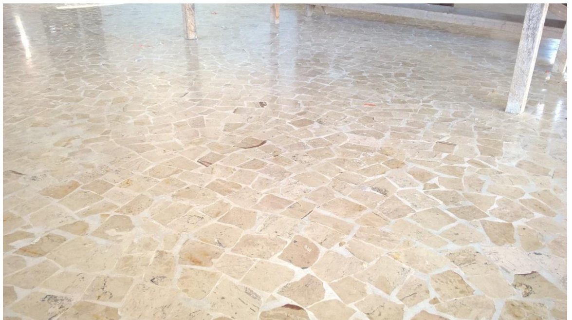
Figura 28 – Região finalizada próxima a cozinha
