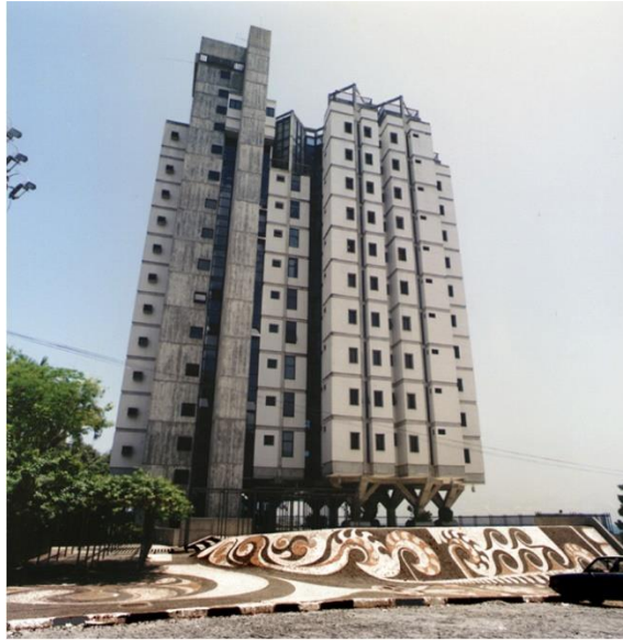
Figura 3 – Calçamento do Edifício Monsenhor Marques, Salvador. Brasil.
