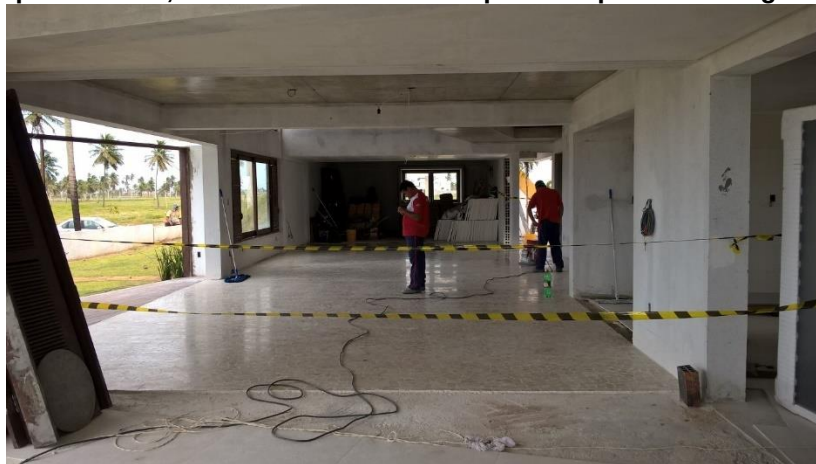
Figura 23 – Atenção ao nível final do pavimento de pedras em relação ao nível final do piso de porcelanato, este será assentado no primeiro plano da imagem
