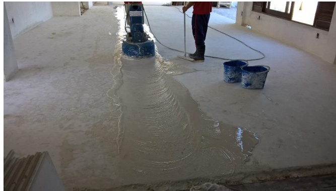
Figura 19 – Maquinário mais estável, melhor acabamento.
