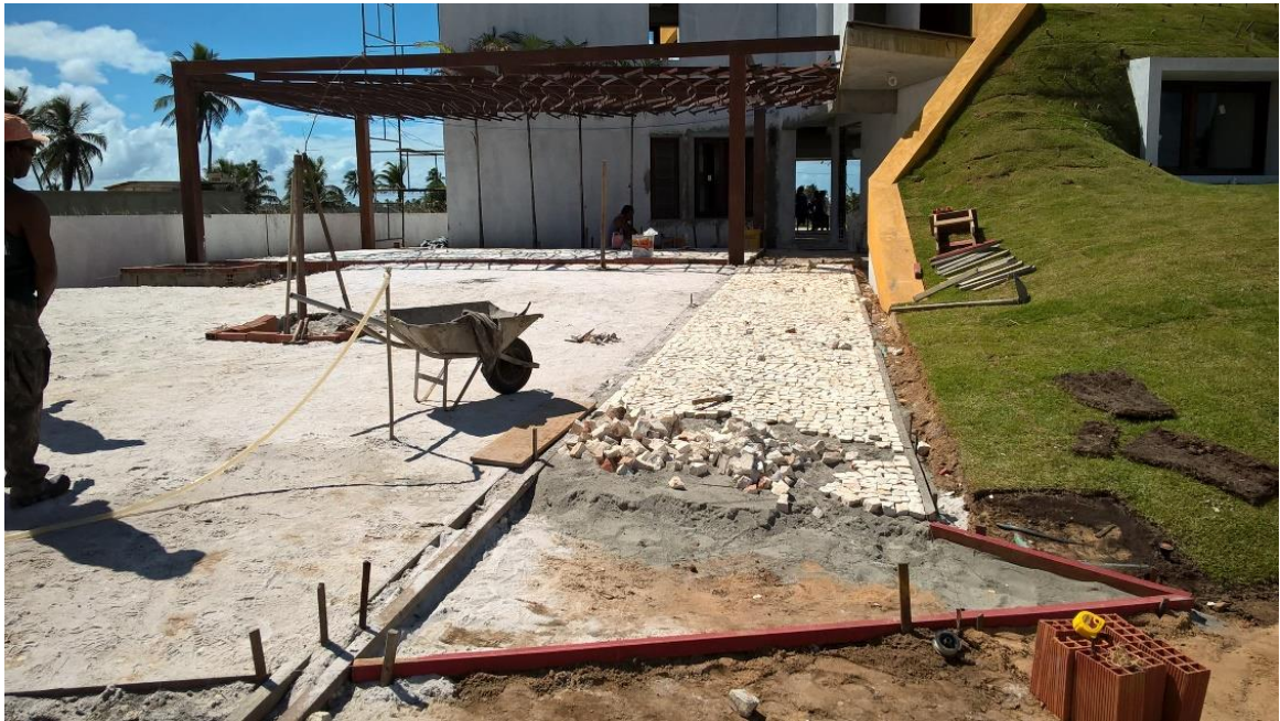
Figura 36 – Visão geral da rampa
