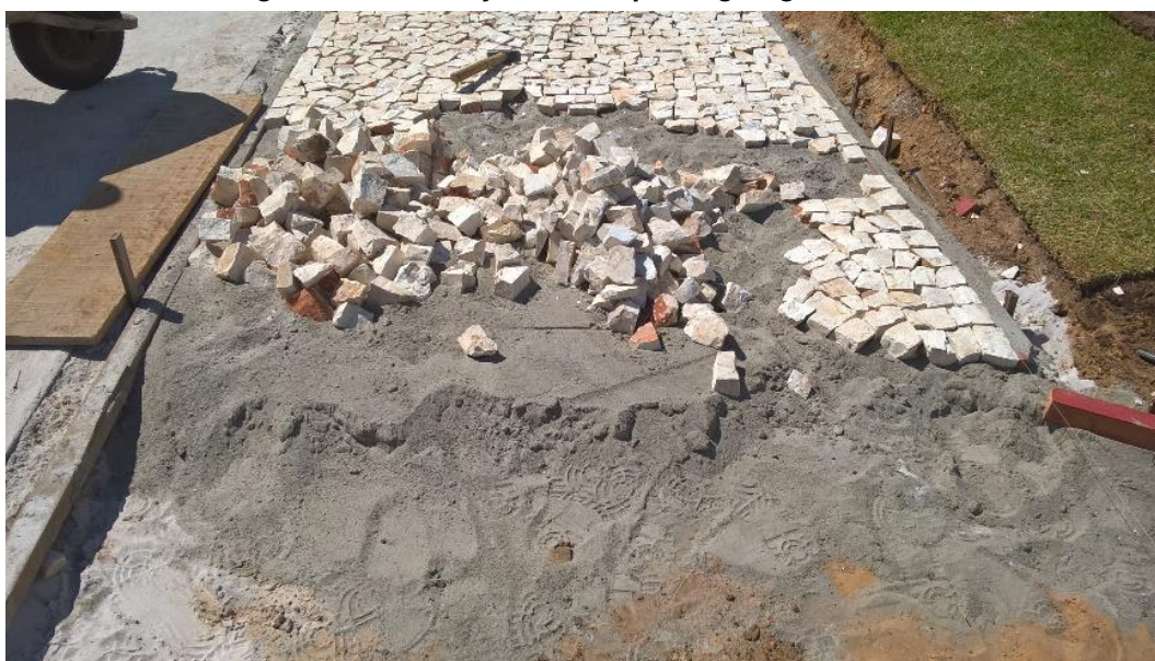
Figura 35 – Execução da rampa da garagem
