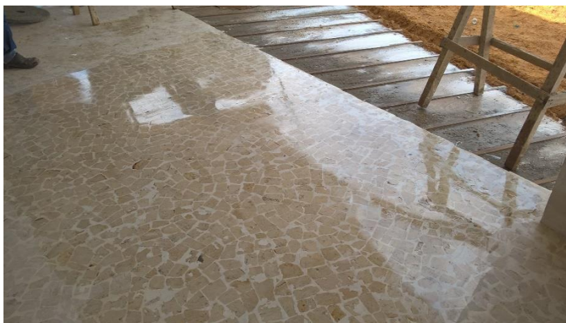
Figura 18 – Detalhe da etapa finalizada
