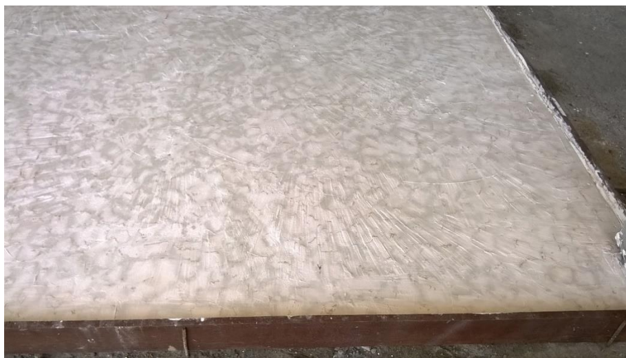
Figura 15 – Detalhe do rejuntamento
