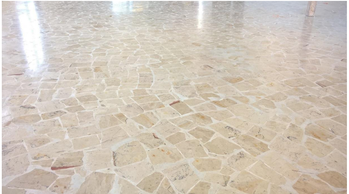
Figura 29 – As pedras portuguesas polidas, impermeabilizadas e aplicadas em ambiente interno
