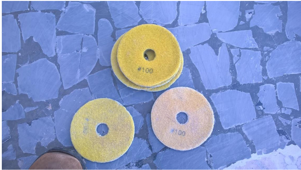
Figura 32 – Detalhe do rejuntamento com cimento branco pigmentado e das lixas utilizadas para o nivelamento da superfície
