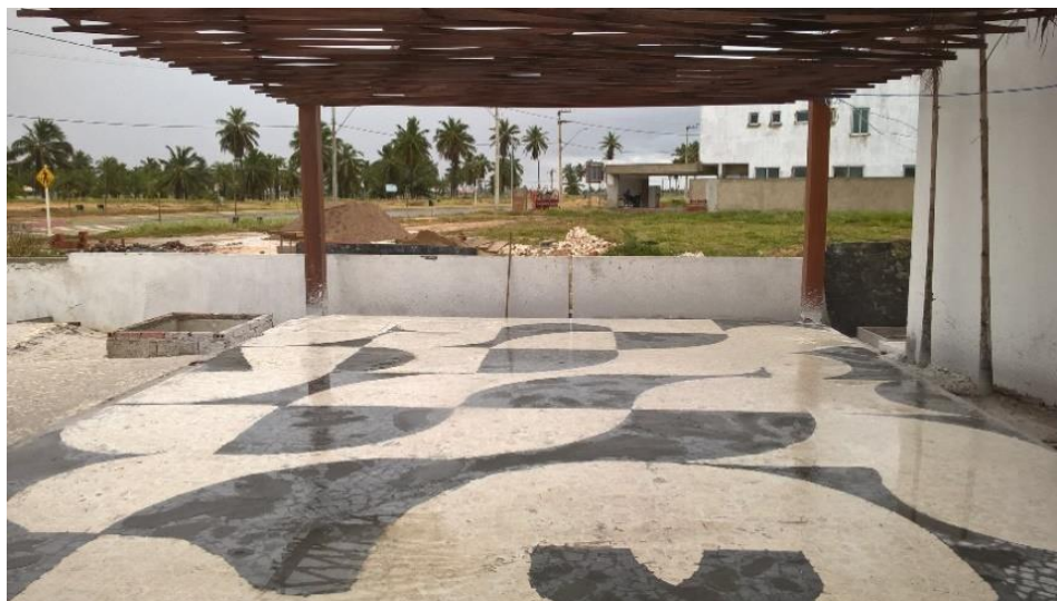
Figura 31 – Rejuntamento finalizado e o início do polimento
