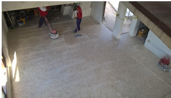
Figura 20 – Acabamento em etapa de finalização
