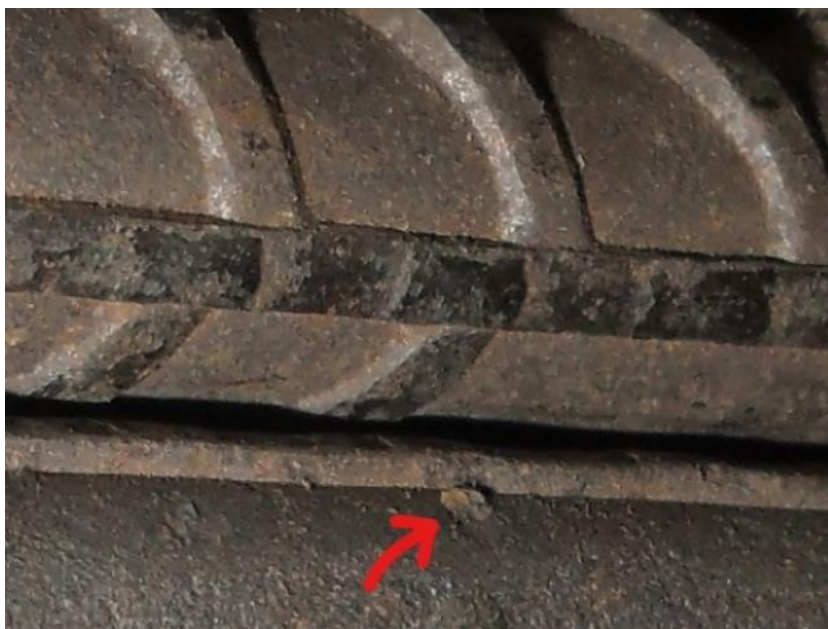
Figura 4.7 – Exemplo formação de escama em barra de aço
