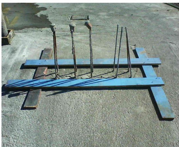
Figura 13: Gastalho e espera para colocação das armaduras do pilar
