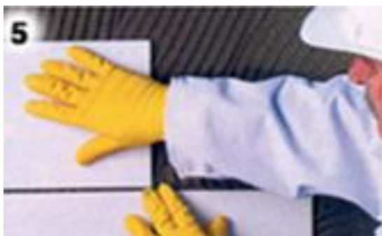
Assentamento da cerâmica.
