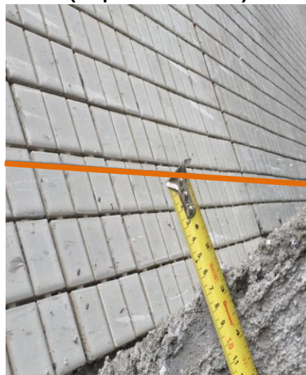
Figura 21: Espessura de 7 cm para enchimento (empreendimento 2)
