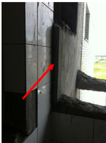
Figura 14: Base pronta para aplicação da pastilha (empreendimento 1)
