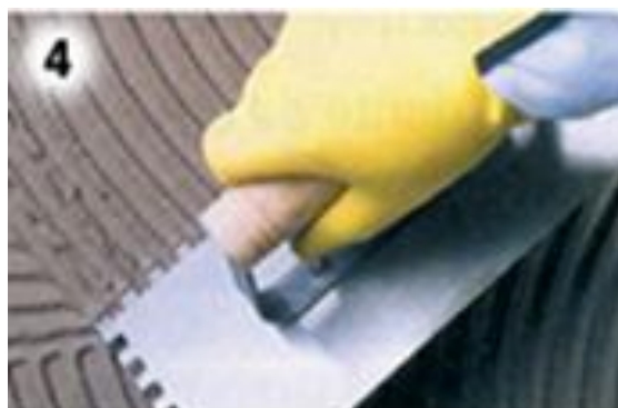
Aplicação da argamassa colante
