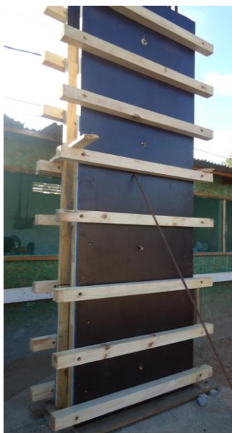
Figura 2: Fechamento e travamento da forma do pilar (empreendimento 1)
