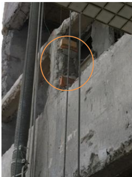
Figura 16: Espessura da mestra para reboco (empreendimento1)
