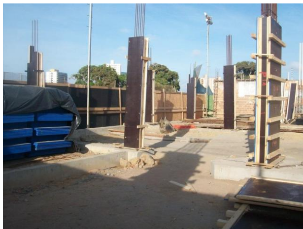
Figura 3: Pilares com fôrma fechada e travada (empreendimento 1)
