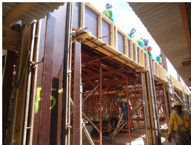
Figura 4: Fechamento, travamento de vigas e pilares e escoramento da laje (empreendimento 1)
