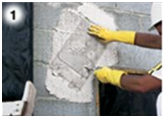
Chapisco de alvenaria externa.
