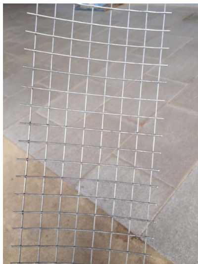
Figura 19: Tela aplicada entre as chapadas (empreendimento 2)
