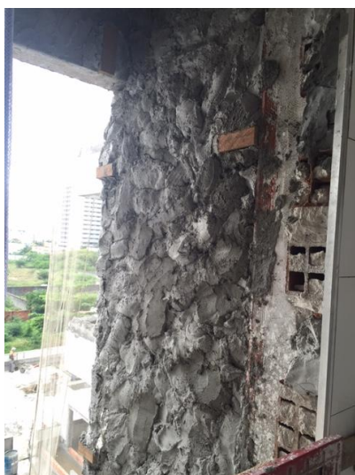
Figura 17: Aplicação da chapada do emboço (empreendimento 2)
