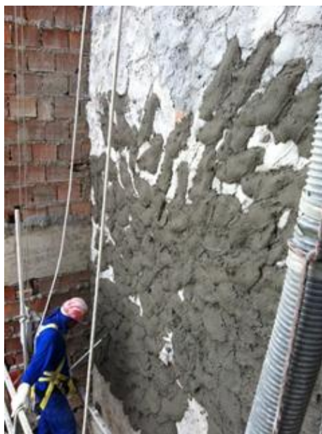
Figura 15: Segunda camada de reboco
