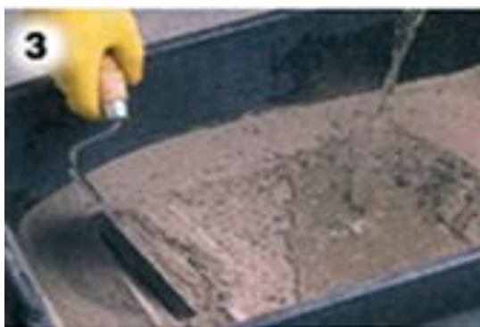
Mistura da argamassa
