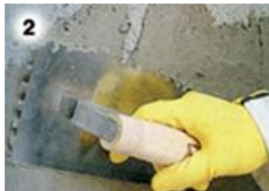
Camada de emboço
