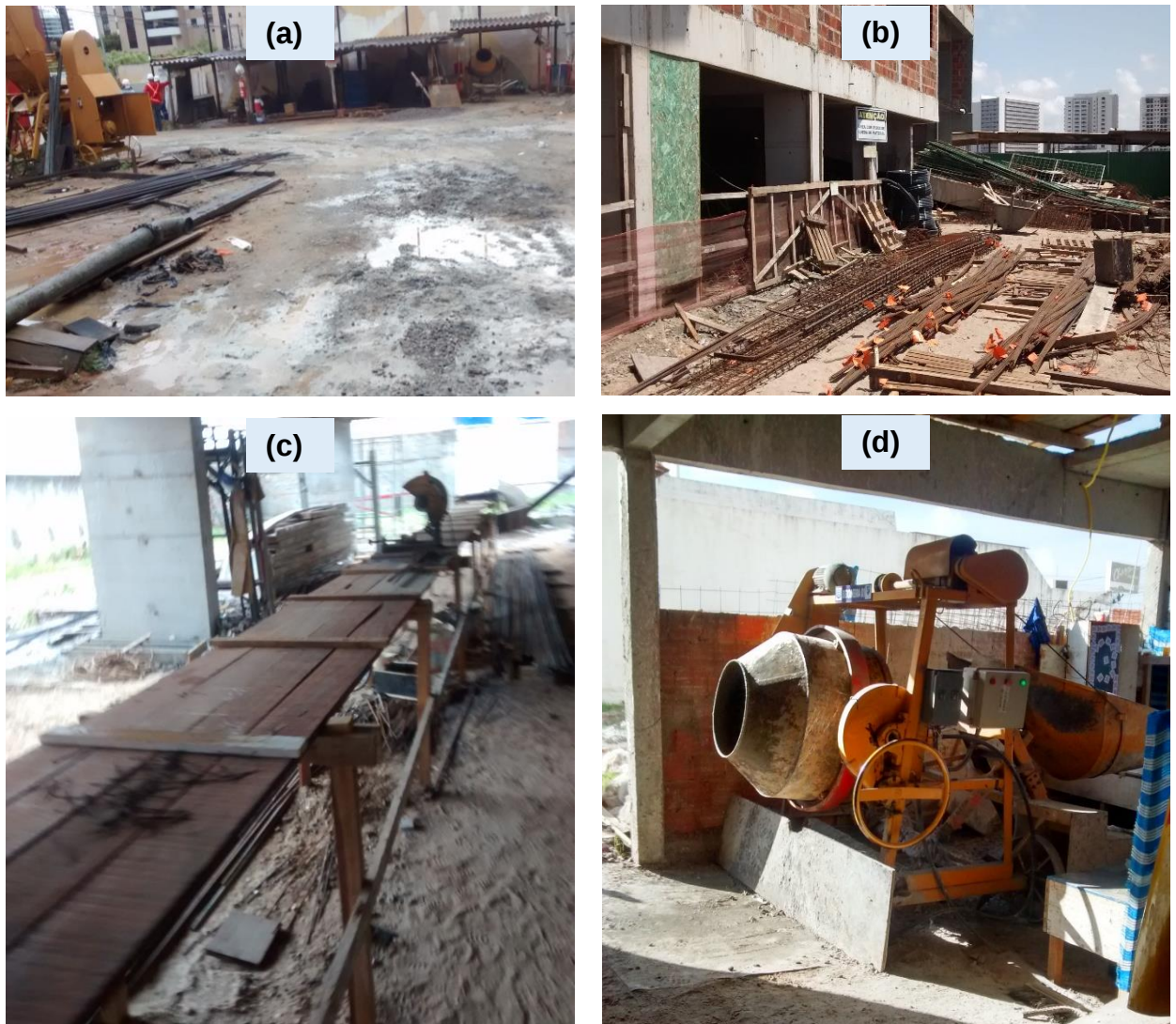
Figura 03 - Áreas Operacionais – (a) Pátio, (b) Central de Armação, (c) Estoque, (d) Betoneira
