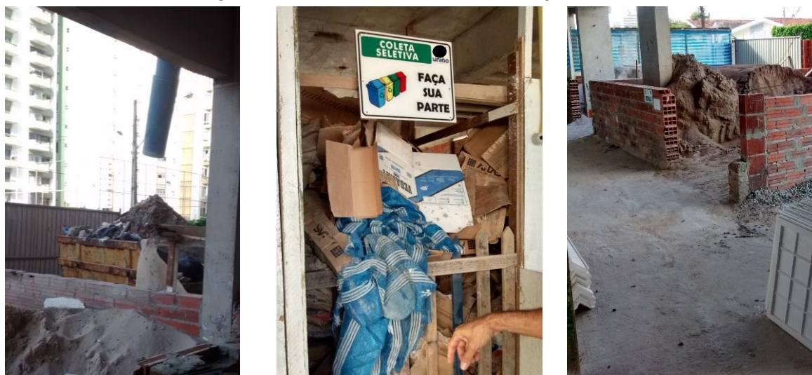
Figura 33 – Resíduo no canteiro da Empresa D
