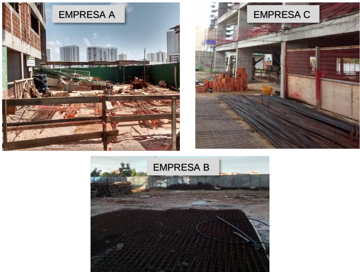
Figura 27 – Estoque do aço nos canteiros estudados
