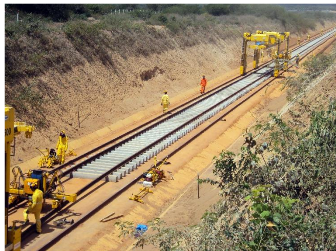
Figura 07 – Canteiro de obra Longo e Estreito –Ferrovia entre Lucas do Rio Verde (MT) e Campinorte (GO)
