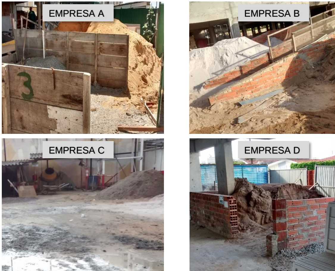
Figura 28 – Armazenamento de materiais nos canteiros
