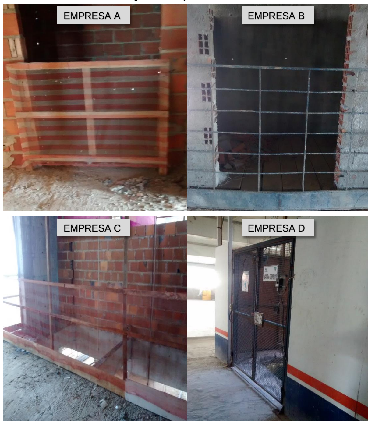
Figura 21 – Poço do elevador
