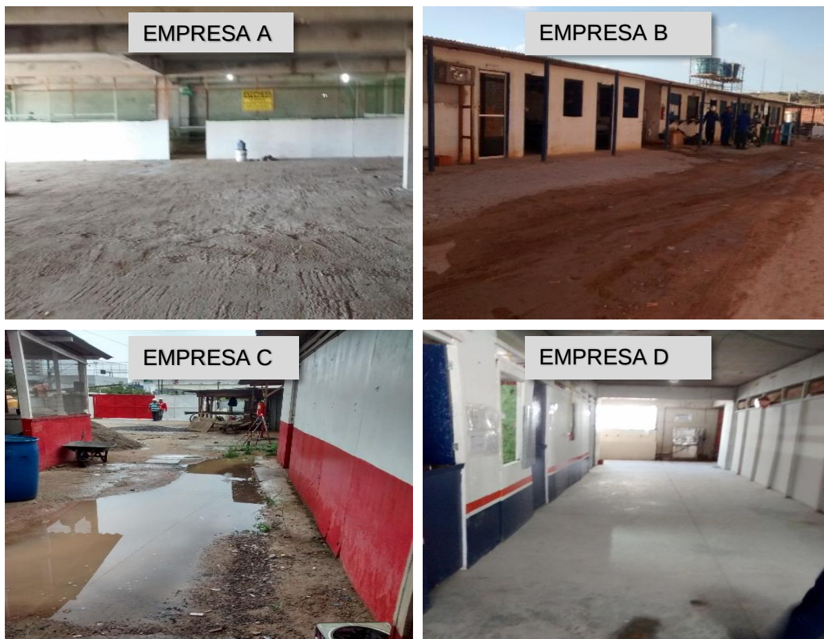
Figura 17 – Caminhos, calçadas dos canteiros
