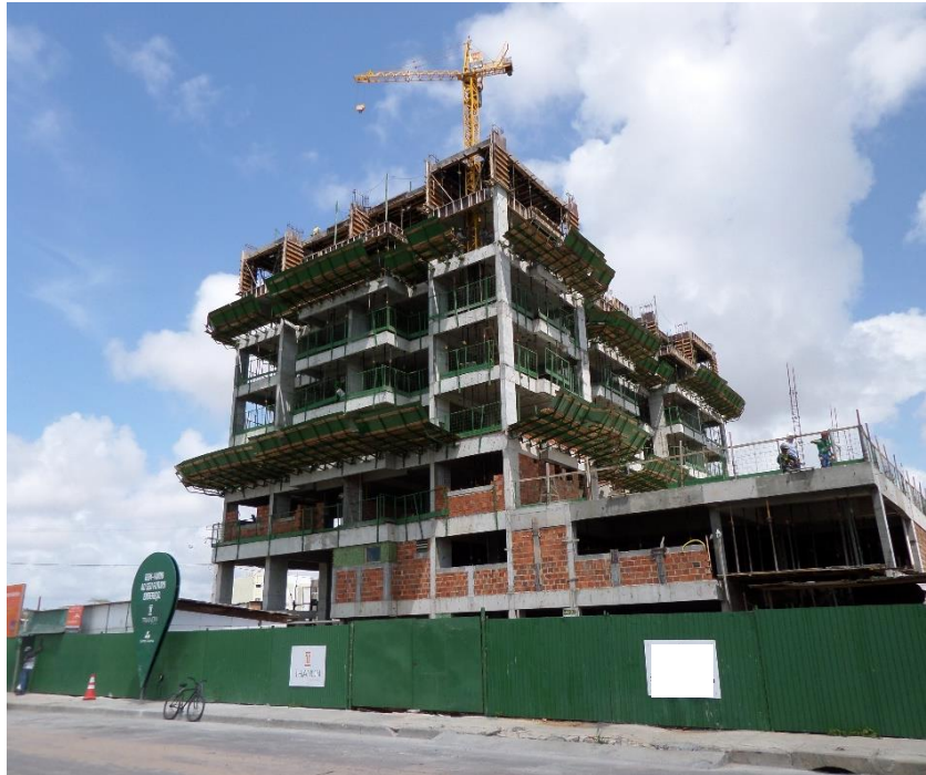
Figura 04 – Canteiro Restrito – Empreendimento Residencial vertical
