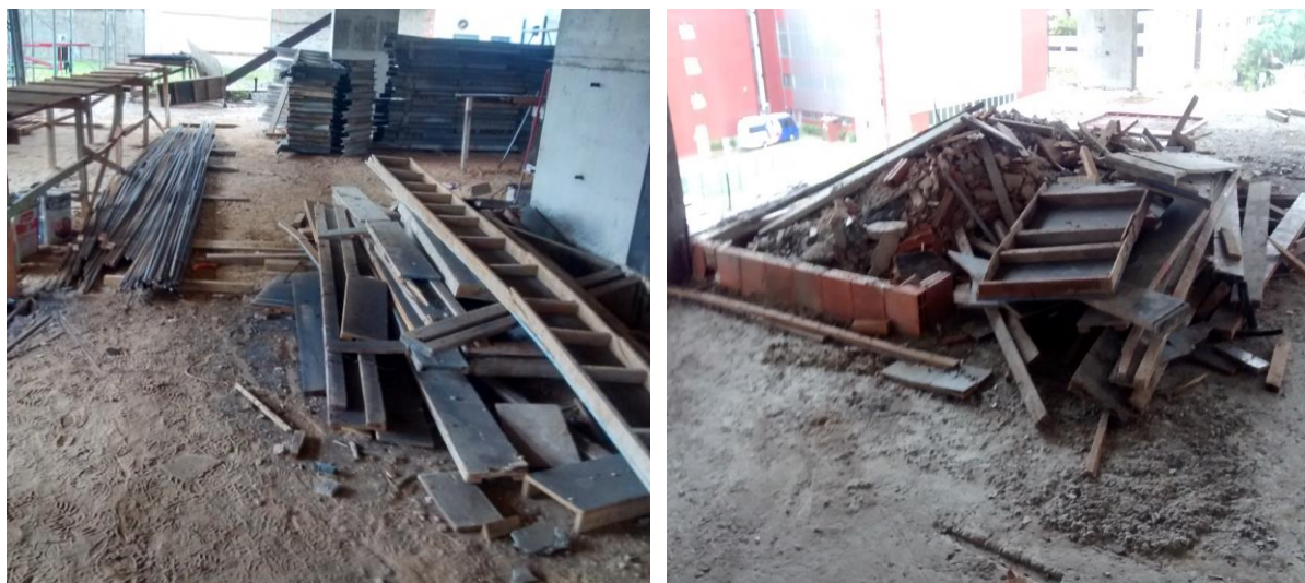
Figura 32 – Resíduo espalhado pela obra no Canteiro da Empresa C
