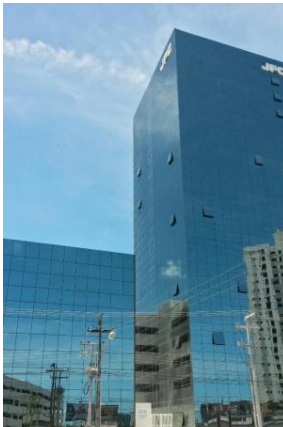
Figura 2.5 - Vidro refletivo aplicado em fachada
