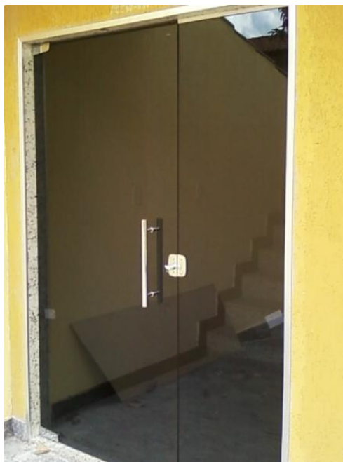
Figura 2.9 - Vidro temperado empregado em portas
