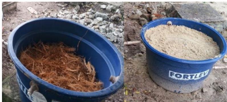
Figura 4: Caixas com o maciço filtrante.
