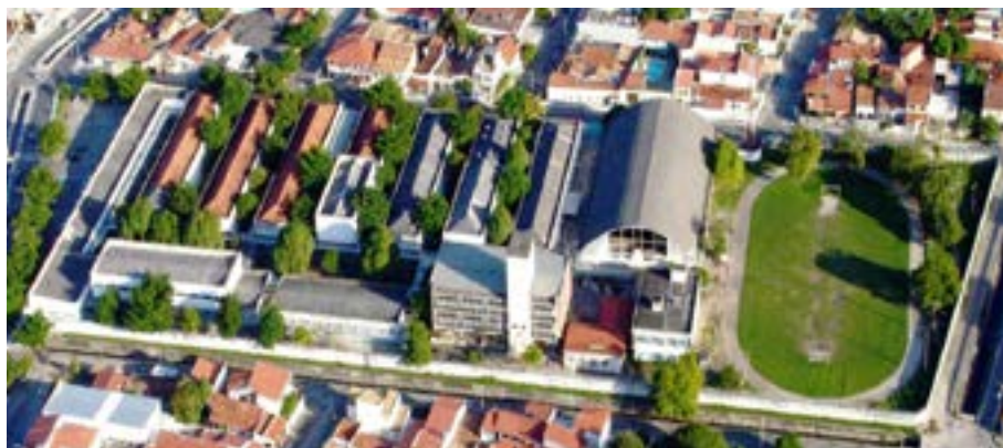
Figura 1- Vista aérea do IFS- Campus Aracaju
