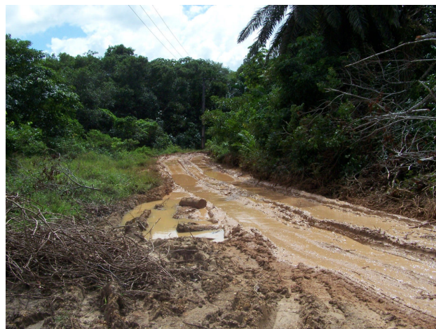
Figura 3. Vias de circulação interna do Instituto Federal de Sergipe, onde não há pavimentação.
