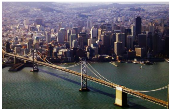
Figura 4 - Ponte São Francisco-Oakland
