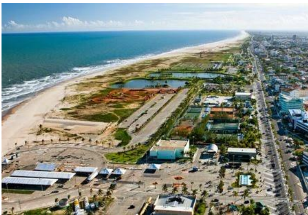
Figura 01: Vista aérea da Orla de Atalaia, em Aracaju/SE Fonte: http://passareladoartesanato.blogspot.com
