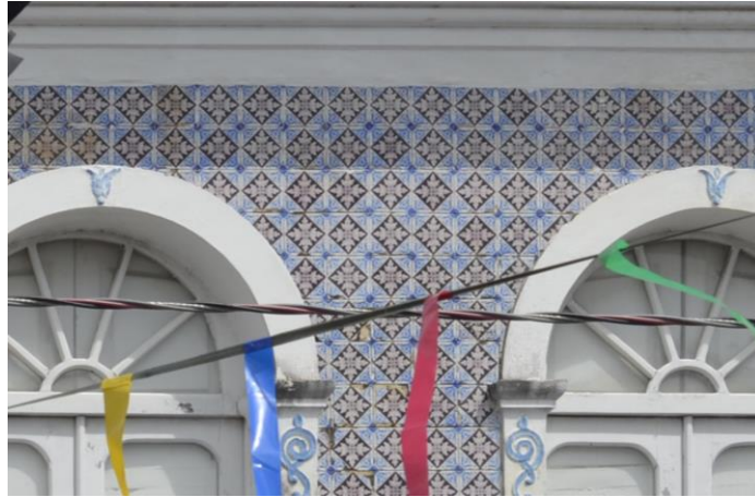
Figura 35 - As saliências dos detalhes arquitetônicos da platibanda proporcionam um sombreamento nos azulejos situados na parte superior da fachada
