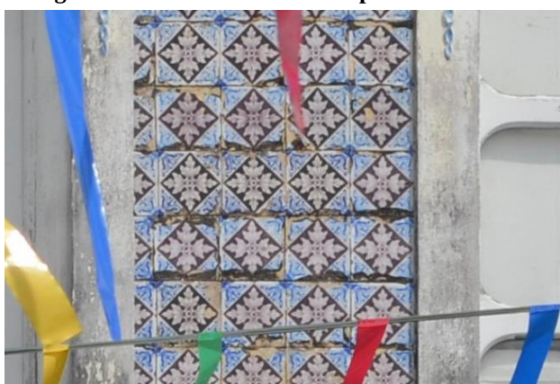
Figura 40 – Perda do vidrado a partir das arestas
