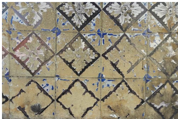
Figura 39 – Perda do vidrado segundo a cor
