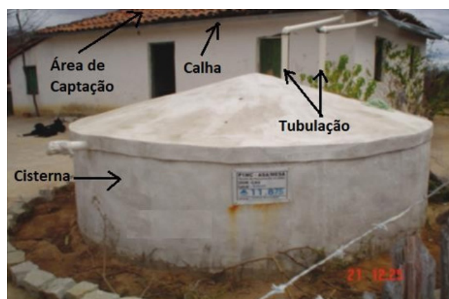
Figura 2: Partes de sistema de captação e aproveitamento de água pluvial. Fonte: BRASIL (2013)
