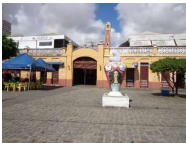
Figura 5: Entrada do Mercado Antônio Franco pela Rua Rio Branco
