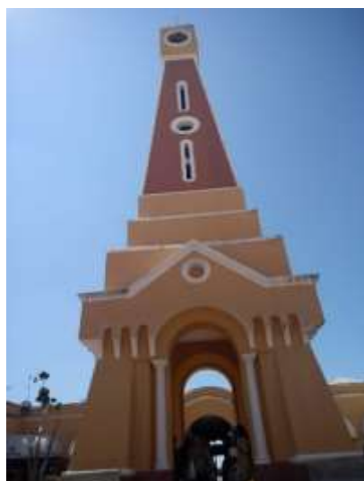
Figura 7: Torre do relógio do Mercado Municipal Antônio Franco
